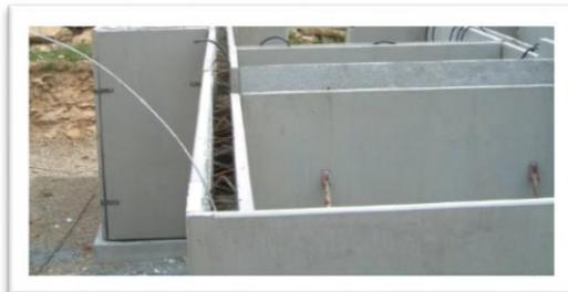
Die tragenden und aussteifenden Innenwände werden gemäß statischer Berechnung und nach Wahl des Auftragnehmers hergestellt. Die Rohbauhöhe beträgt ca. 2,30m.
