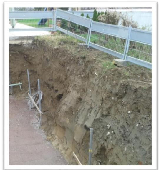
Wir weisen ausdrücklich darauf hin, dass es im Bereich der verfüllten Baugrube zu Setzungen kommen kann, daher sollte der Außenanlagenbauer vor Beginn seiner Arbeiten nochmals nachverdichten. Setzungen sind im Bereich der Wiederverfüllung auf dem Grundstück (u.a. bei Baugrube, Kanalarbeiten, etc.) üblich. Sofern sich Setzungen zeigen sollten, fallen diese nicht unter die Gewährleistungsansprüche (Bauwerkvertrag §6).
